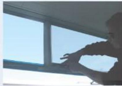
安裝太陽隔熱膜會增加玻璃的熱應力，在極端情況下，增加的熱應力可能會令玻璃破裂，在下列情況下，建議諮詢製造商有關太陽隔熱膜應用的合適性：
