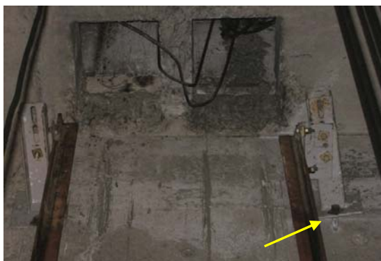
圖 11 – 對重導軌托架變形（從 35 樓層向升降機井道望時見於右邊）。
