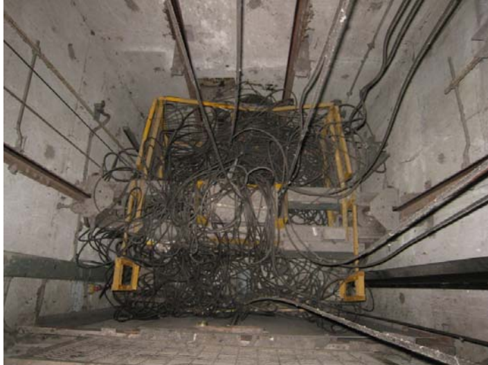
圖 1 – 編號 L32 升降機機廂頂及懸吊纜索。
