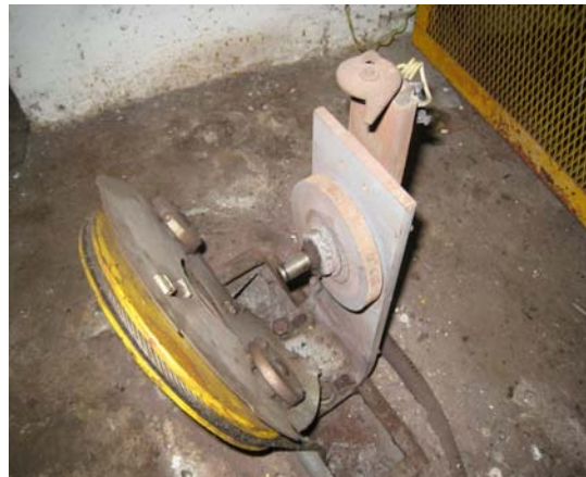
圖 4 – 受損的升降機限速器。
