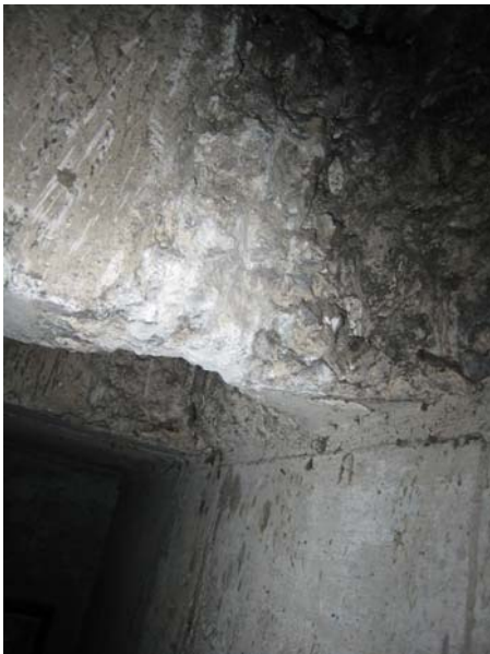
圖 7 – 混凝土樓板發現新的磨蝕痕跡。
