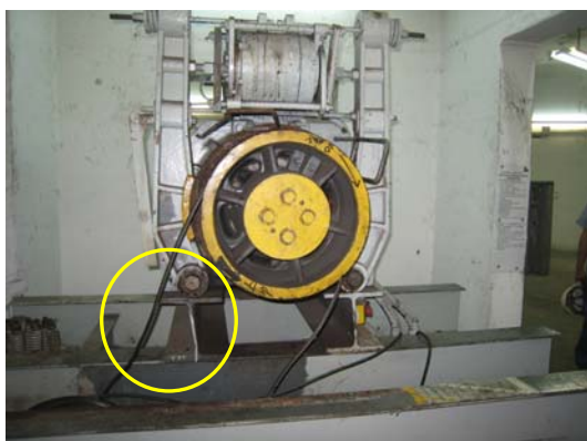
圖 5A – 升降機發動機的工字形金屬桁樑變形。
