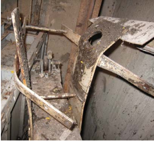
圖 6A – 對重滑輪托架上的纜索刮痕。 圖 6B – 對重滑輪托架上的纜索刮痕及滑輪刮痕放大圖。
