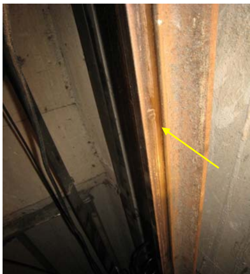
圖 9 – 導軌上的刮痕。
