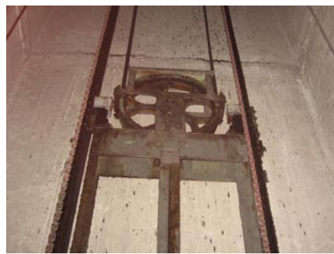
圖 4 - 升降機對重裝置沒有發現損壞。
