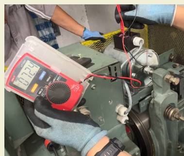
量度制動線圈的輸入電壓
