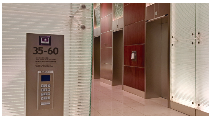
裝有DCS升降機的大廈
