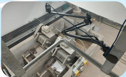
利用支架固定在天台上
