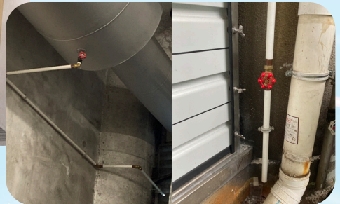
延長排水喉長度至地面能直接觸及的地方
