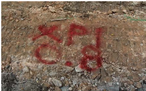
相片五(標示地下電纜的位置及深度)
