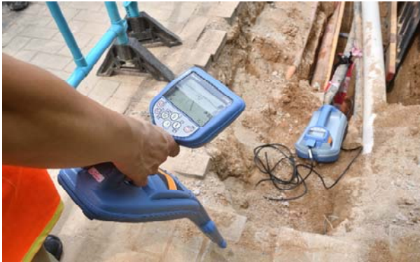
相片五(標示地下電纜的位置及深度)
