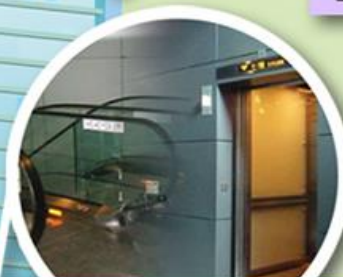
升降機及自動梯裝置 Lift & escalator installation
