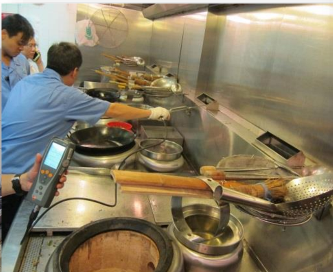
爐具是否燃燒正常?
