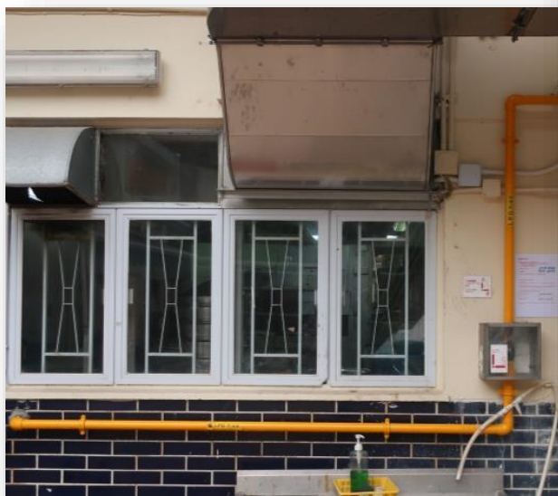
檢查石油氣管道鏽蝕情況
