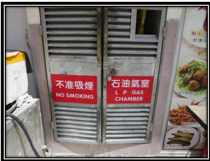
檢查石油氣瓶室是否完整
