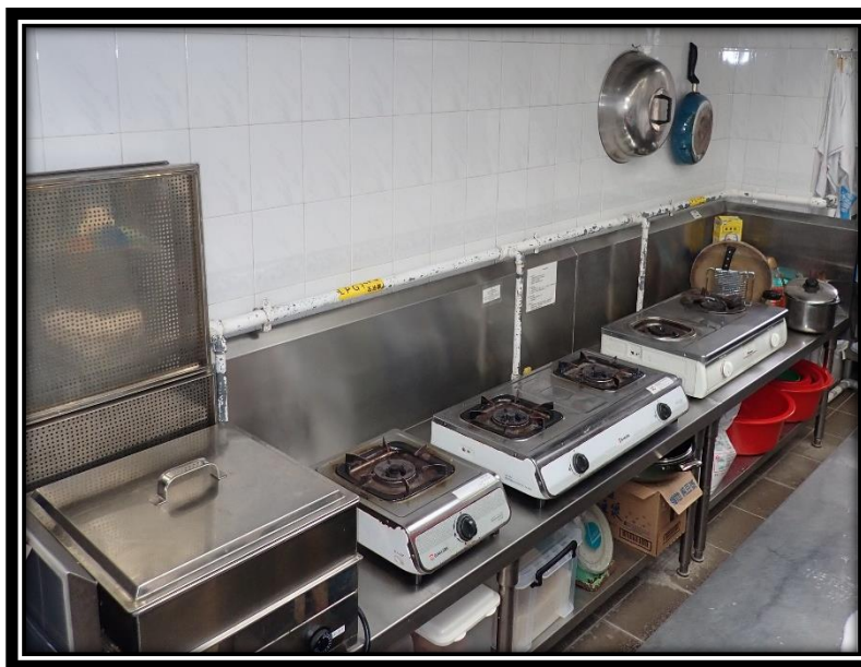
檢查石油氣喉有否鏽蝕和損傷
