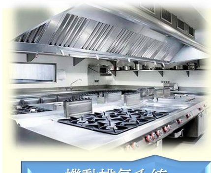
機動排氣系統 運作狀況
