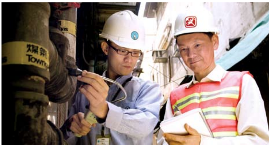
加強巡查使上給供氣分喉事故大幅減少。
