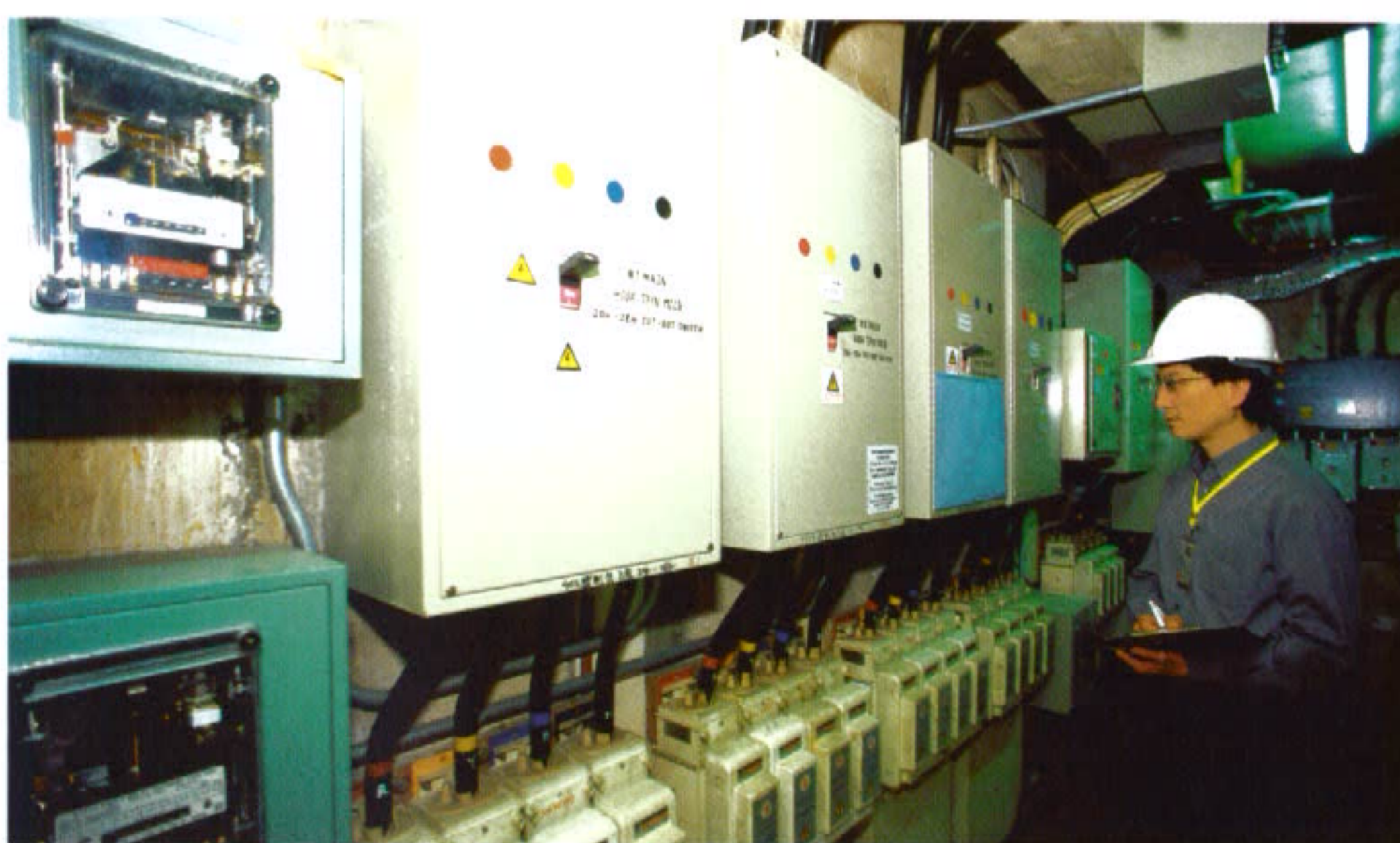
實地視察對確保固定電力裝置的安全至為重要，在2002年。
