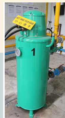
圖2: 非明火直熱式汽化器
