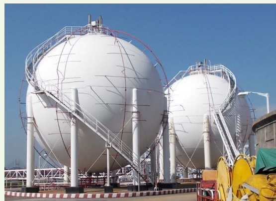
青衣石油氣儲藏庫
