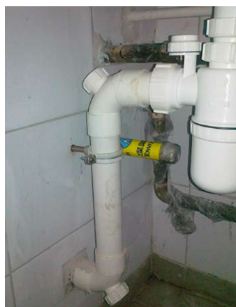
圖三：拆除氣錶後，用中英文清楚標明喉管內存有氣體
