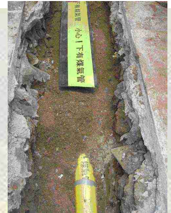
圖一：鋪設在道路或行人路下面的氣體供氣管道
