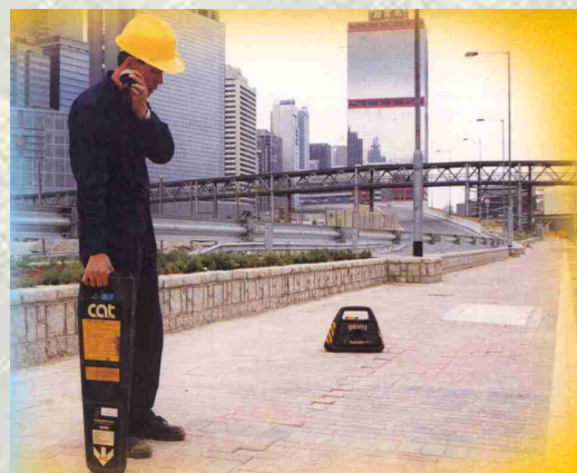
圖四：使用喉管定位器找尋氣體喉管的位置
