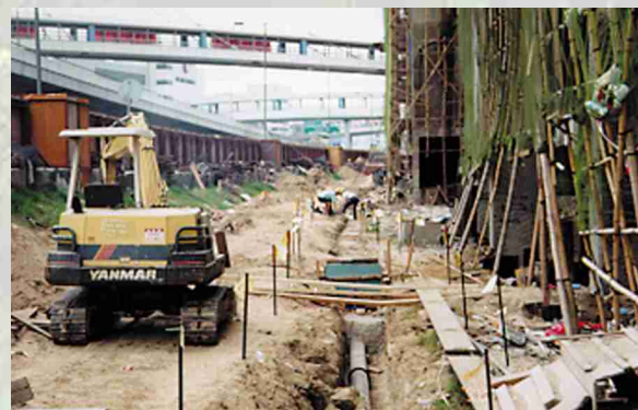
圖六：採取安全掘地方法以確保在氣體喉管與挖掘地方之間有足夠的分隔距離
