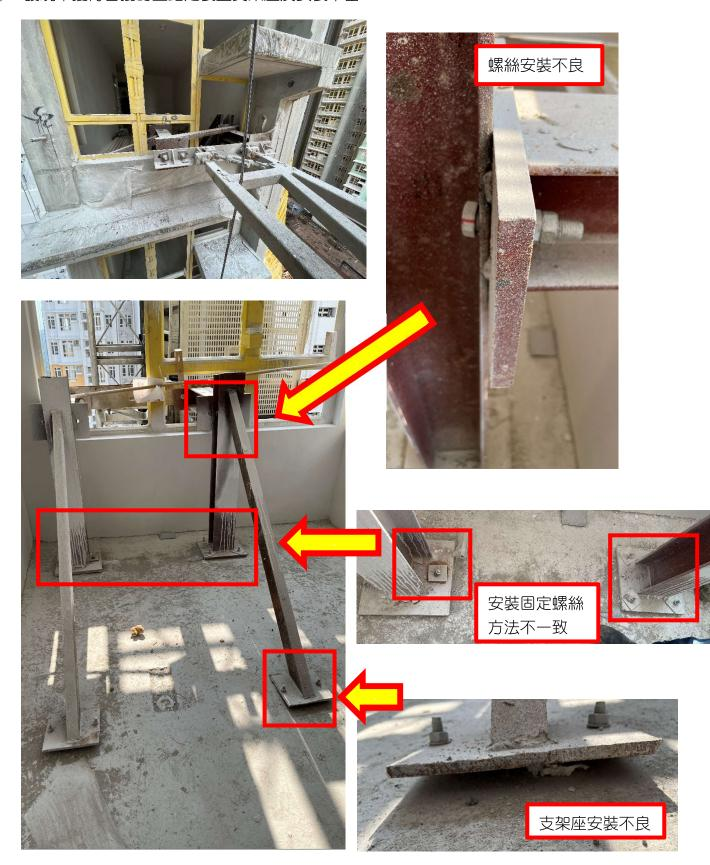
5) 發現支撐棚架的狗臂架與機架之間的間隙不足
