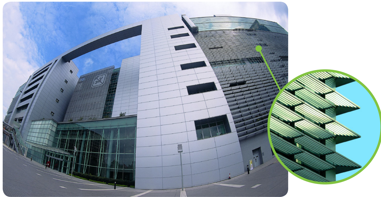
機電工程署外部遮陽設備 資料來源：機電工程署
