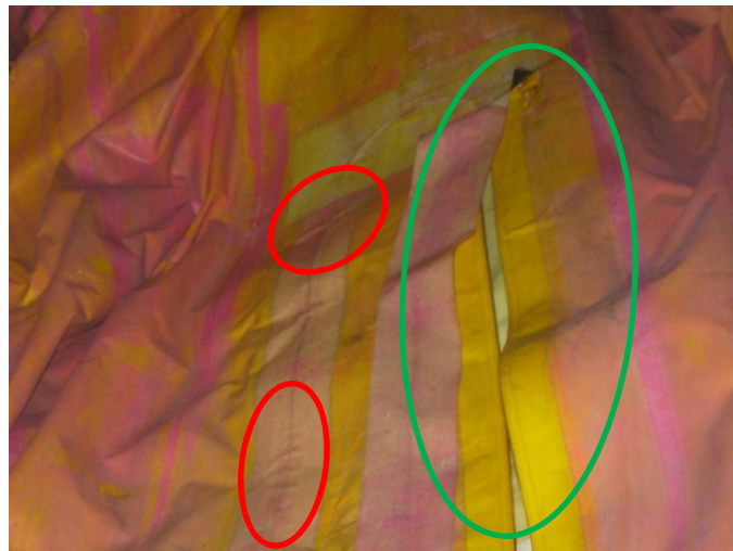
圖 5b - 於左封條內中央出現分離部份(紅圈示) 右邊封條與快速放氣口拉葉完全分離 (綠圈示)
