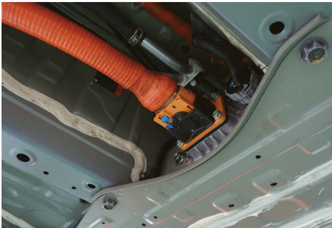
其中一種日本車款的高壓電源斷路器，拔除維修連接器以切斷汽車高壓電源
