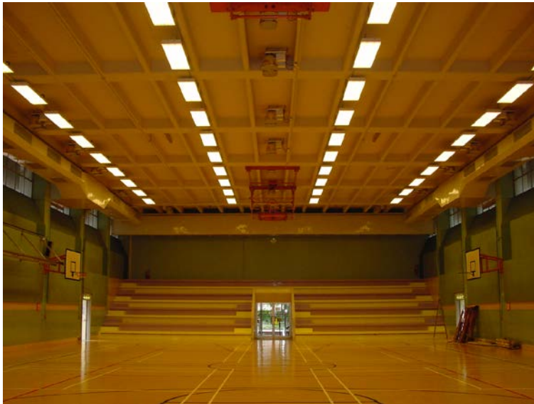
圖 6：東啟德室內運動場新 T5 照明系統的視覺環境
