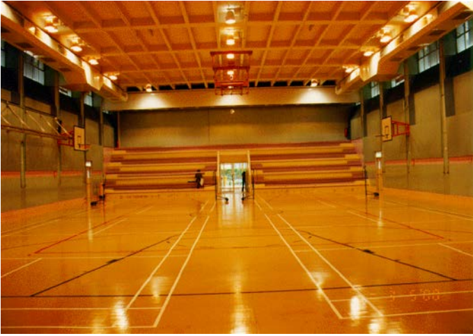
圖 9：高強度放電燈在地板的反射眩光
