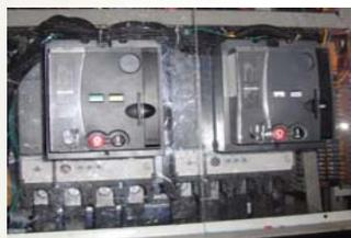
須設有機械性及電氣性連鎖的四極轉換器件，連接於正常及後備電源，以確保不平衡的中性線電流與故障電流能返回正確的電源
