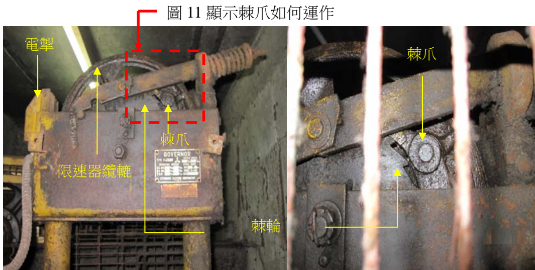
圖 8：升降機的限速器。左邊的照片顯示限速器的棘爪已被打開，並接近棘輪兩齒之間的凹處。
