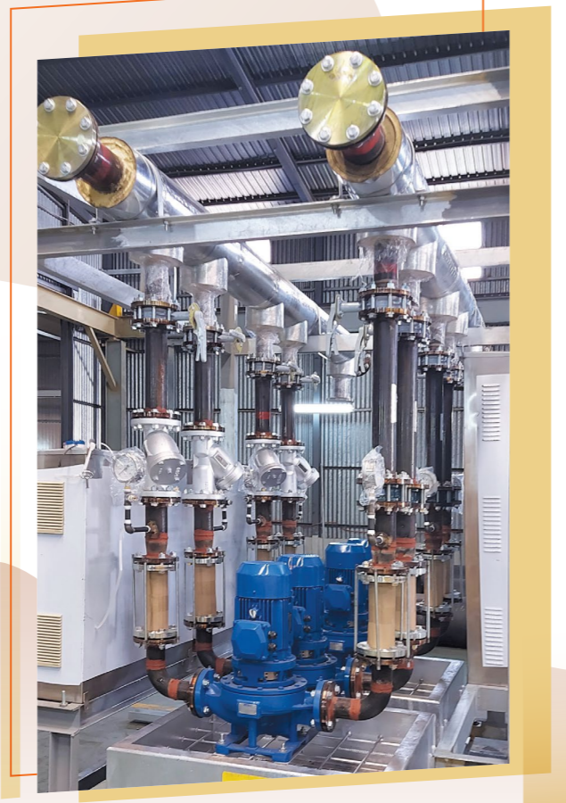
機電署善用多項創新技術為大龍獸醫化驗所更換製冷機，包括首次使用機電裝備合成法預製機電組件。
