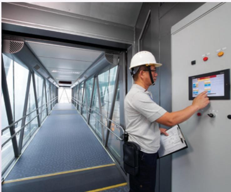
在新啟德郵輪碼頭，我們的工作人員透過船橋內的控制屏測試及校驗登船橋的操作。
