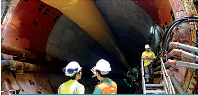
廣深港高速鐵路（香港段）的隧道工程。 Tunnel Construction of the Guangzhou-Shenzhen-Hong Kong Express Rail Link (Hong Kong Section).
