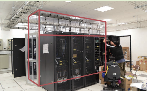
我們於伺服器上加建熱氣流通道，將冷和熱的空氣分隔在不同的通道中，以求達至最佳散熱效能。 Staff building a hot aisle containment separating hot and cold aisles in the server room to achieve the best cooling efficiency.
