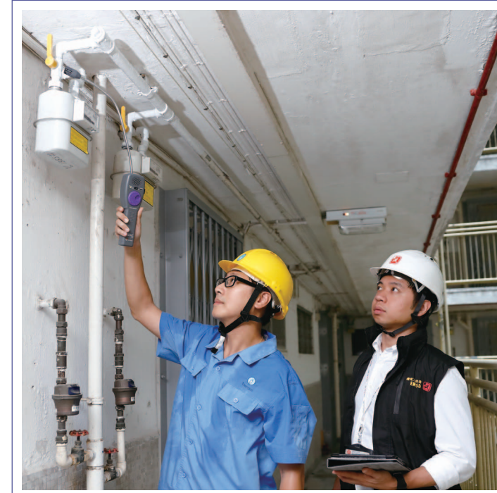
煤氣公司員工為公共屋邨煤氣管道進行安全檢查，機電署同事在旁監察。
