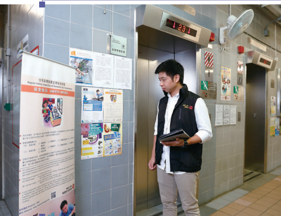
機電署員工於青衣某公共屋邨進行氣體安全巡查。該屋邨也是煤氣公司為「長期沒接受安全檢查服務」用戶，進行定期安全檢查計劃的屋邨之一。
