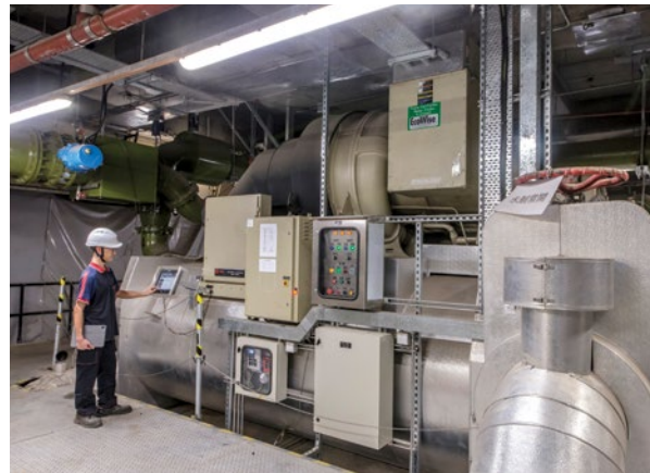
屯門醫院的製冷機組設備使用低全球變暖潛能值的雪種，相比傳統雪種，新型雪種大大減低了對全球暖化的影響。
