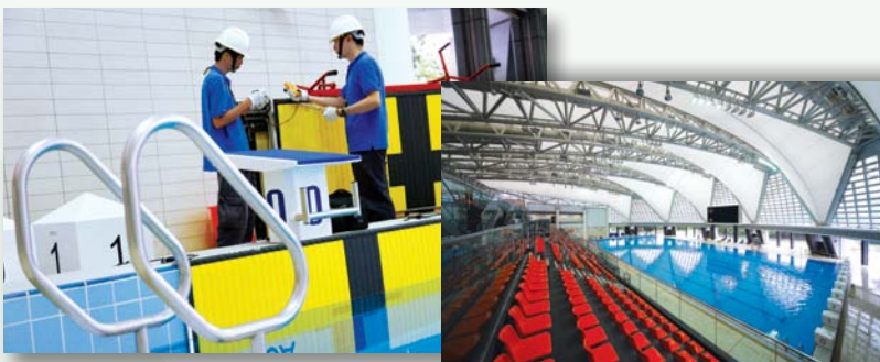
我們為東涌游泳池提供機電、空調、屋宇裝備及電子系統維修保養與操作服務，使場地活動能順利進行。
