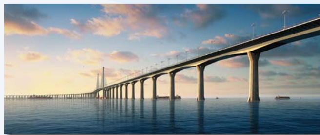
我們獲路政署委託，為港珠澳大橋香港接線、香港口岸及屯門至赤鱸角連接路等項目，提供有關機電諮詢及技術審核的顧問服務。
