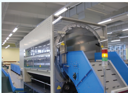
機電工程署維修的「自動分信戳郵機」，可以分隔開厚度超過7毫米的郵件，以便人手處理。 The Culler, maintained by EMSD, can filter out mails with thickness of over 7mm for manual processing.
