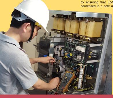
我們在一個月內完成 檢查所有已安裝的 諧波過濾器,確保 類似的消防事故不再 發生。
