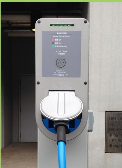
IEC 61851 充電模式3使用符合IEC 62196標準的專用插座和插頭，可傳送更高的充電電流，節省充電時間多達60%。
