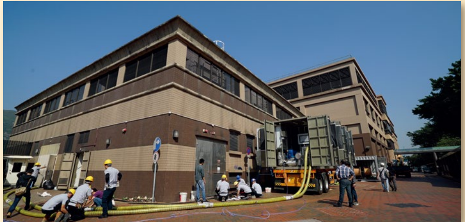
「流動製冷系統」先後在青山醫院(上圖)、大埔王少清家庭醫學中心和將軍澳醫院進行實地測試，只需數小時就能完成安裝接駁。
