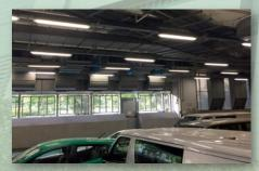
總部大樓的辦公室、汽車工場、走火通道、洗手間、行車通道等地方的傳統燈具已更換為發光二極管燈具,其使用壽命較長,耗電量亦較低。
