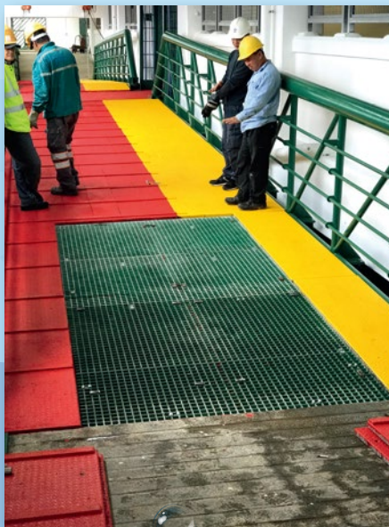
我們在紅磡(南)渡輪碼頭的可升降登船橋試用可揭式不鏽鋼板及網格纖維物料(左圖)。風暴來臨前，把可升降登船橋的不鏽鋼面移走(右圖)，留下堅固的網格纖維物料疏水，可減少被海浪衝擊造成的損毀。
