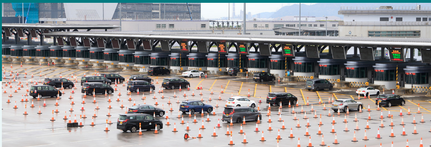
機電署提升港珠澳大橋香港口岸設施，為「粵車南下」做好準備。
